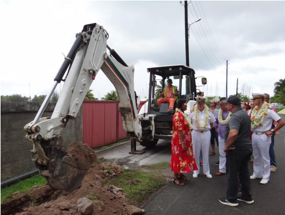
Visite du chantier de la rénovation des canalisations d'eau potable à Uturoa
